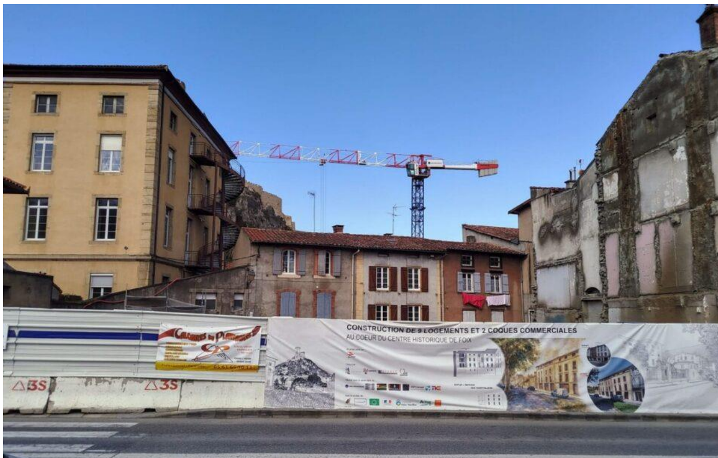
Le chantier prévoit la construction de 9 logements et 2 coques commerciales. (©Ville de Foix)
